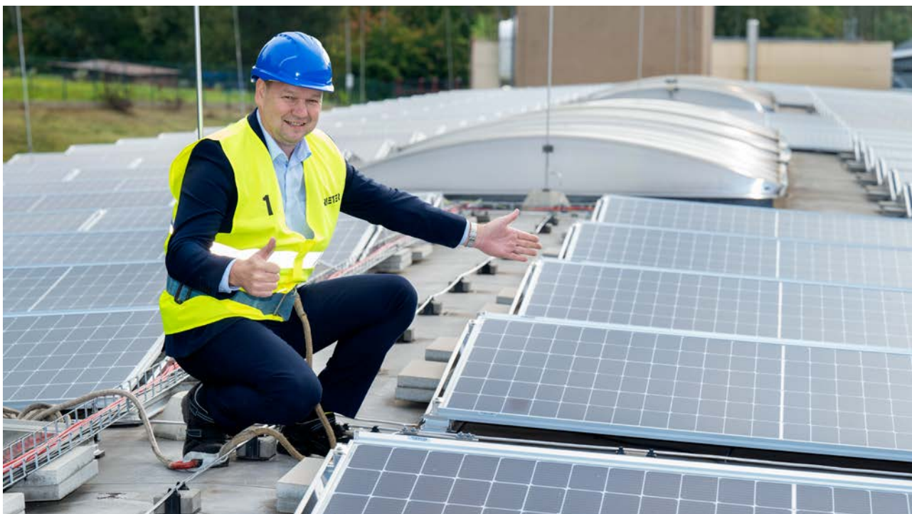
Pavel Kubicek, Head Operations, Rieter CZ, zeigt die neueste Photovoltaikanlage am Standort Ústí nad Orlicí, Tschechische Republik.
